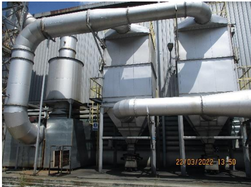
รูปที่ 1 ระบบบำบัดมลพิษทางอากาศ (Dust Collector)
