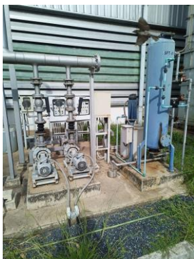
รูปที่ 14 ระบบผลิตน้ำอ่อน (Back Wash)
