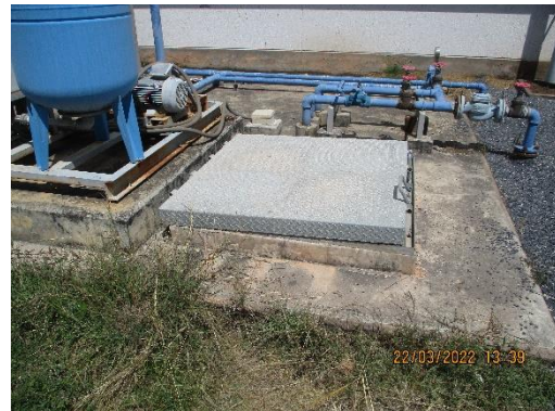
รูปที่ 18 ถังเก็บน้ำประปาขนาด 80 ลบ.ม
